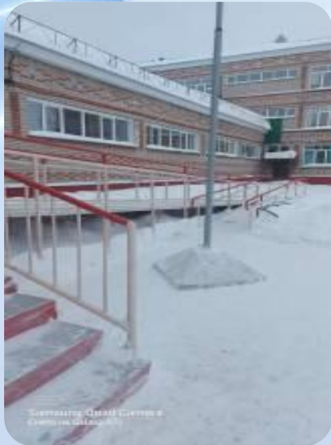
Пандус центрального входа
